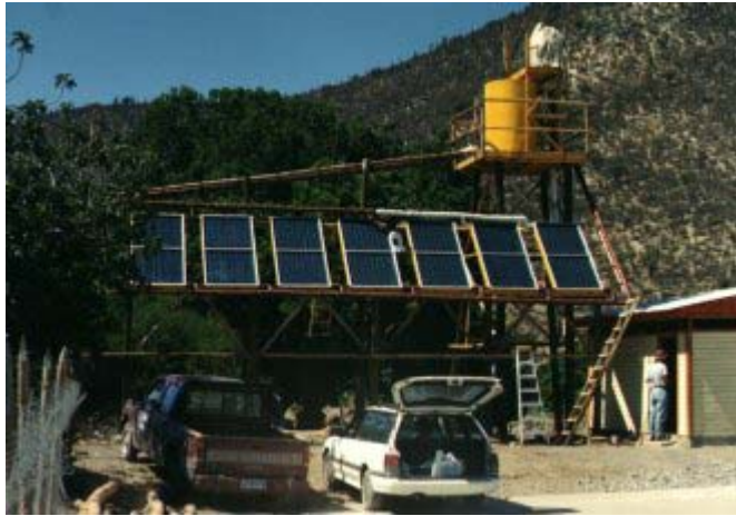
Foto 2: Sistema de agua caliente para escuela en La Viña (Cabildo). Calienta 2000 litros de agua al día
